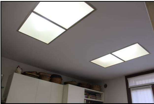
27.- Controsoffitto cucina con plafoniere
