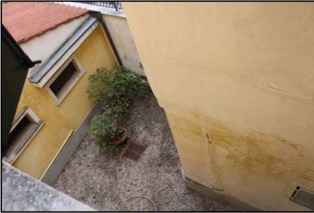
25.- Cortile interno (con caldaietta)
